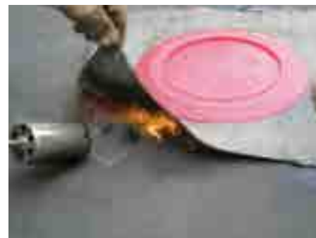
3. A bitumengallért a már lefektetett bitumenlemezhez hegesztjük
