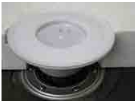
4. A HL85N magasító elemet a hőszigetelés vastagságának megfelelően méretre vágjuk, majd a HL180 vízávezető gyűrűbe helyezzük és a védőfedelelet bepattintjuk
