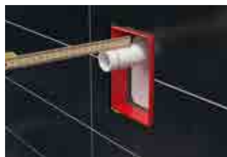
6. Jelölje a menetes hüvelyt a falsíktól 3cm-re!
