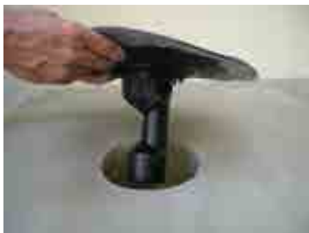
1. A lefolyótestet a védőfedéllel a födémáttörésbe helyezzük
