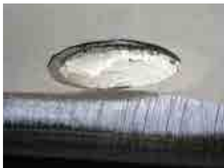
1. A magfuratot elkészítjük Ø 300 mm, bitumen kellőszítés és az első bitumenlemez réteg lefektetése
