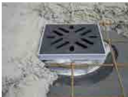
8. Betonnal feltöltjük a végleges szintig
