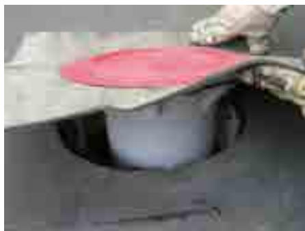
2. A HL616H Perfekt lefolyótestet a búzzárral együtt behelyezzük
