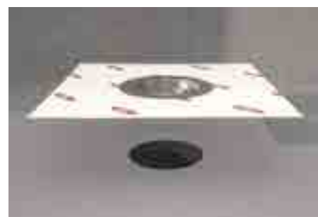
6. A szigetelő gallért a lefolyóba benyomjuk.
