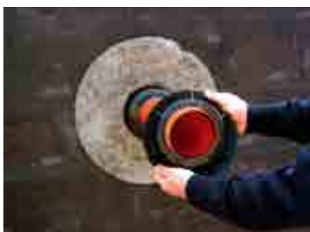
4. A szorítóanyát a csőre ráhúzzuk, gyengén a tömitőelemre csavarjuk
