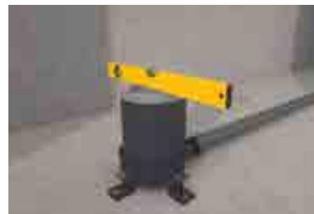
3. A lefolyótestet becsövezzük, a csőlejtést beállítjuk és a szárnyas anyákkal rögzítjük. A lefolyótestet a kép alapján vízszintezzük.
